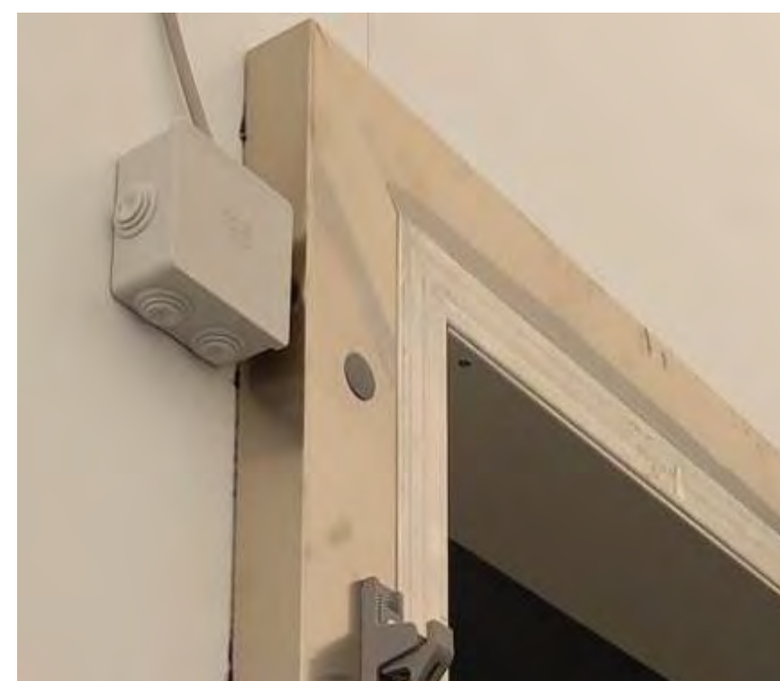
Telaio con rivestimento inox Area di contatto guarnizione in alluminio
