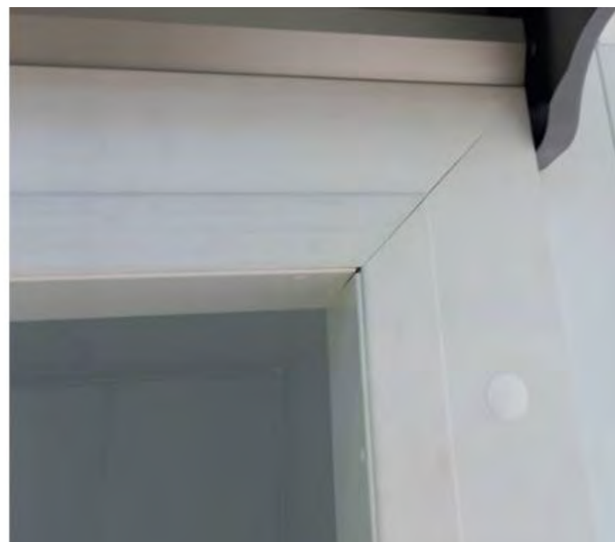
Telaio in PVC Area di contatto guarnizione in PVC
