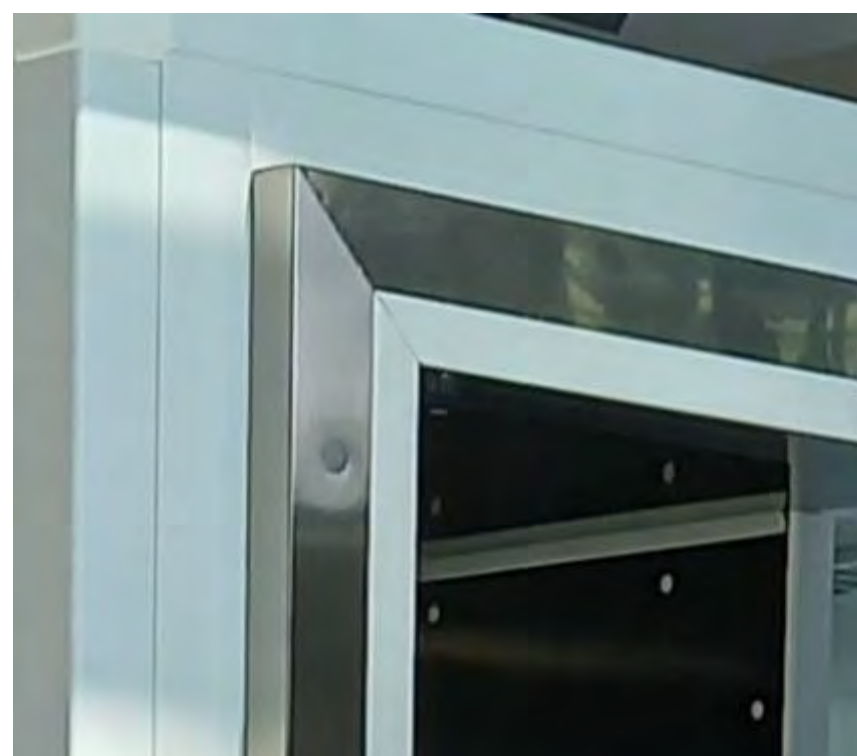
Telaio inox con rivestimento Area di contatto guarnizione in PVC
