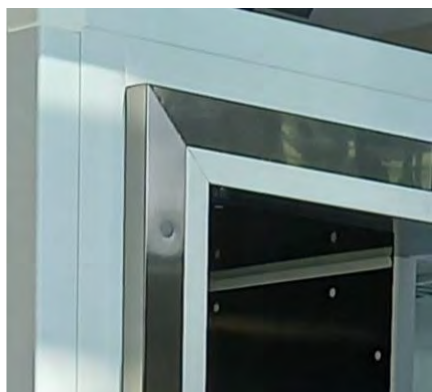
Bâti PVC avec recouvrement inox Couvre cordon chauffant PVC
